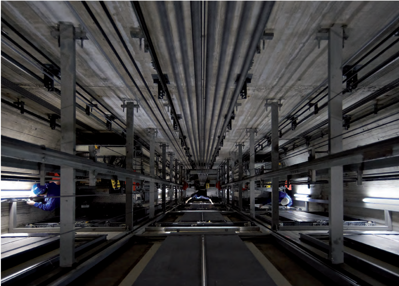
1 Service inspection of a 3-lift group, Bundesagentur für Arbeit, Nuremberg
